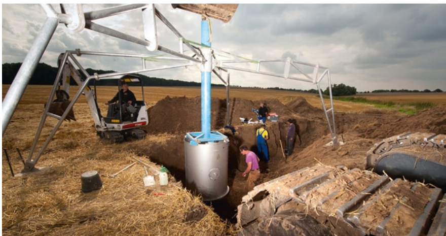
Aufbau von Lysimetern am TERENO-Standort Sauerbach im Harz. Mithilfe der Lysimeter untersuchen die Wissenschaftler den Einfluss des Klimawandels auf den Boden.
