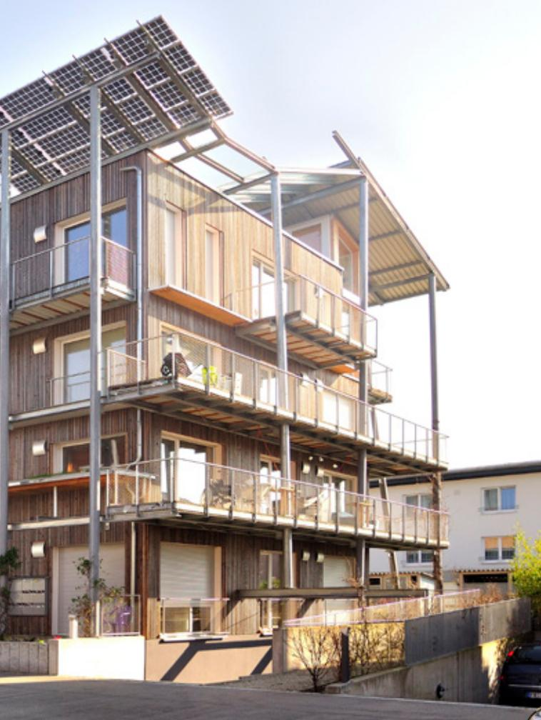
— Dachüberstand zur Beschattung und Nutzung durch Photovoltaikanlagen, umlaufende Terrasse und senkrecht verbaute Holzplatten – das macht ein nachhaltiges Passivhaus des Freiburger Architekten Wolfgang Frey aus.
