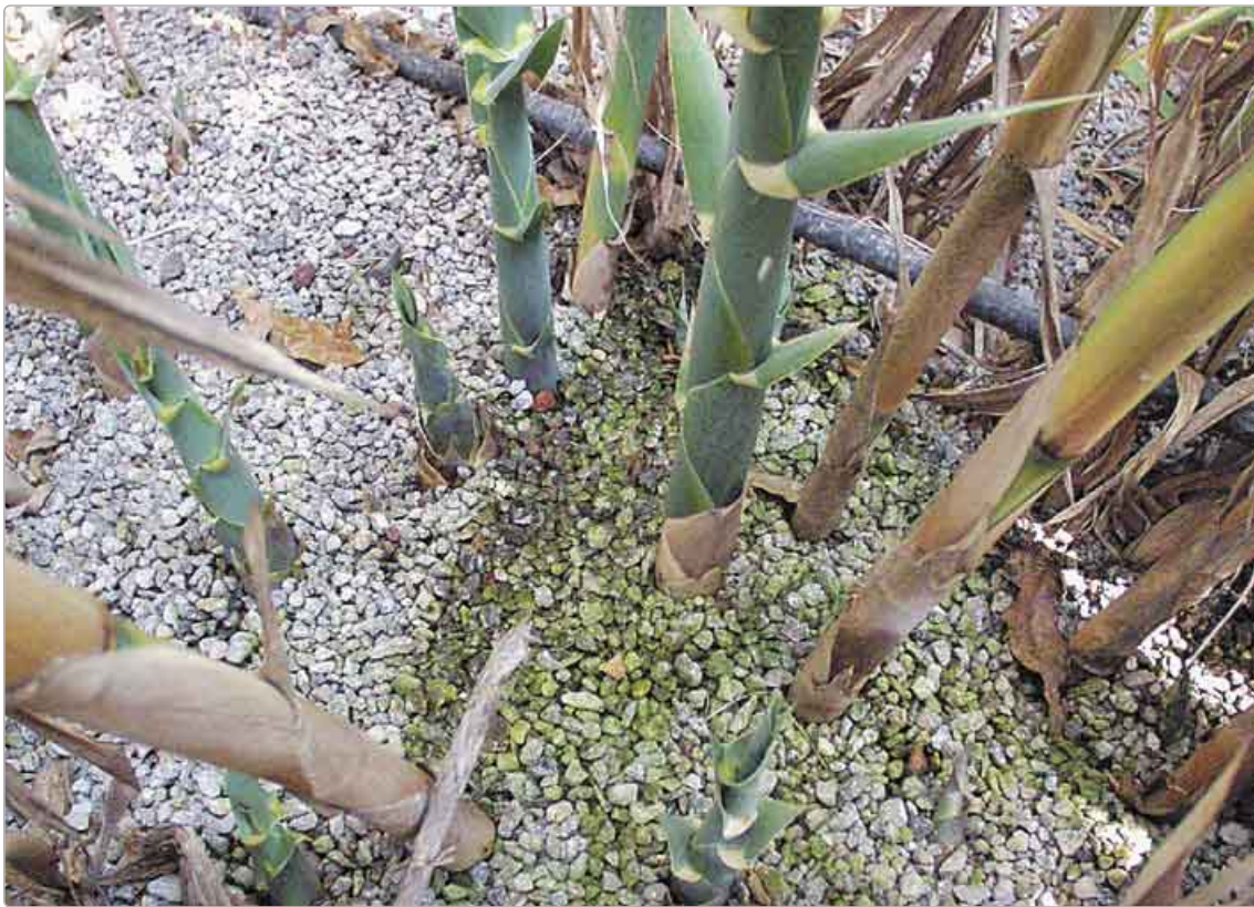
In der Pflanzenkläranlage von Xochitla werden Sumpfpflanzen (Helophyten) eingesetzt. Selbst sauerstoffarme Böden und stehendes Wasser vermag ihr Wachstum nicht zu beeinträchtigen. (Quelle: Peter Mosig, UFZ)
