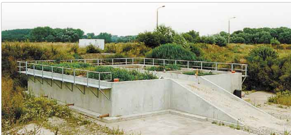
Bild 5: SECON-Versuchsanlage in Kleindalzig zur Vererdung von Baggerschlamm (Quelle: Andreas Zehnsdorf, UFZ)
