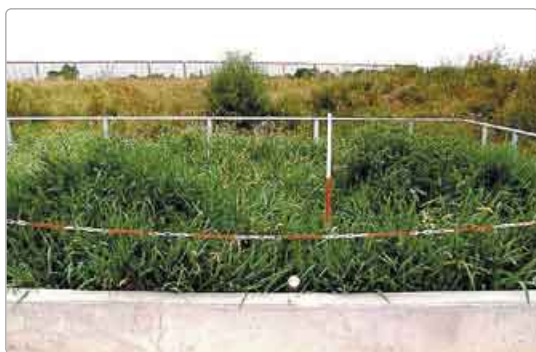
Bild 6a: Befüllung der Konditionierungsbecken mit frisch gebaggertem Schlamm
