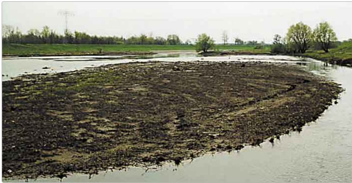
Bild 1: Sedimentablagerungen der Weißen Elster in der Geschiebefalle Kleindalzig bei Leipzig (Quelle: Andreas Zehnsdorf, UFZ)
