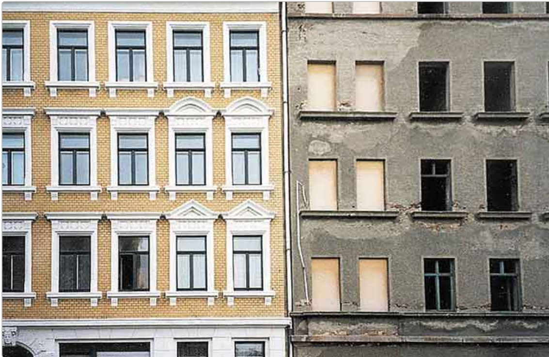
Sanierte und unsanierte Wohnhäuser in enger Nachbarschaft in Leipzig (Quelle: E. u. R. Lehmann, Leipzig)
