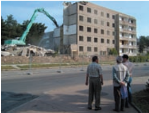
Abb. 7: Bewohner beobachten den Abriss in Hoyers- werda
