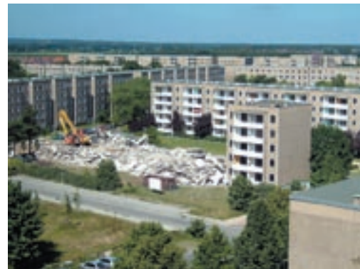
Abb. 6: Laufender Abriss in Hoyerswerda
