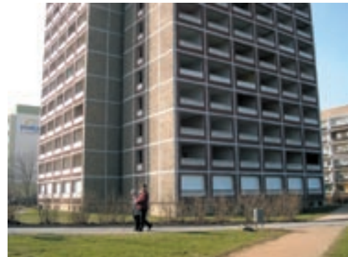
Abb. 2: Leerer Wohnblock in Vorbereitung auf den Abriss
