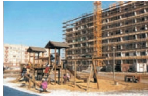
Abb. 4: Vor dem Abriss
