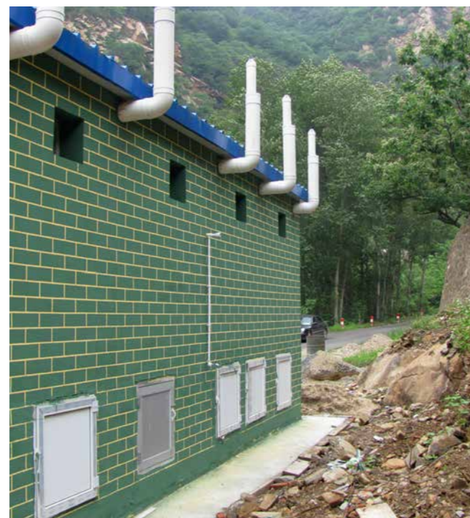
Abb. 19: Neue Komposttoilettenanlage in Huangyukou – Rückansicht mit Trocknungskammern nach Fertigstellung. → Foto: Beijing Water Authority
