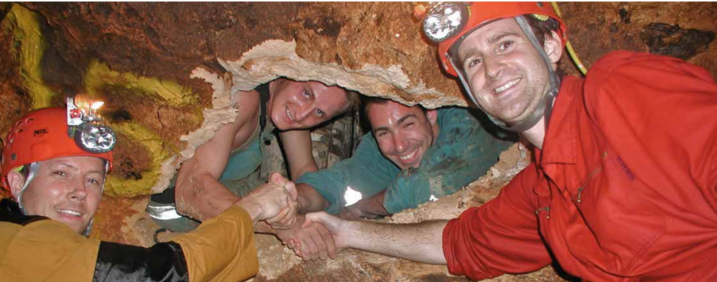
Abb. 77: KIT-Wissenschaftler und Herrenknecht-Ingenieure schaffen „den Durchbruch“: Erfolgreicher Schachtbau bis in 100 Meter Tiefe. Zusammenarbeit von Forschung und Industrie als echte Win-win-Situation. → Foto: IWRM-Projekt Indonesien
